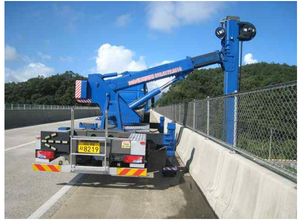
교량점검차를 이용한 근접조사
