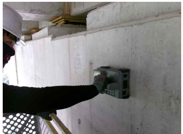
교량점검차를 이용한 근접조사
